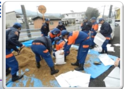
台風に備えて土嚢作り
